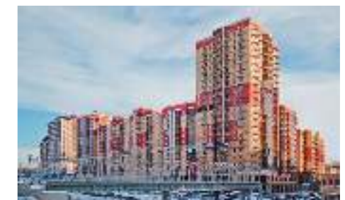
ЖК «Солнечный город», Казань «АК БАРС Строй»
