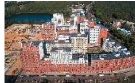
ЖК «Новокрасново», МО «Тройка РЭД»
